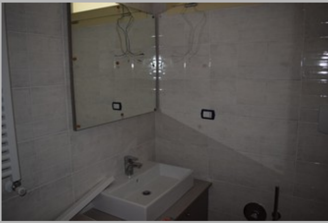
Dettaglio del lavandino con pareti lucide in rilievo, chiare
